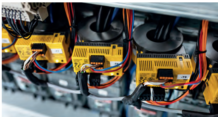
Differenzstromsensoren RCMB301 mit einem Wandler-Innendurchmesser von 35 mm
